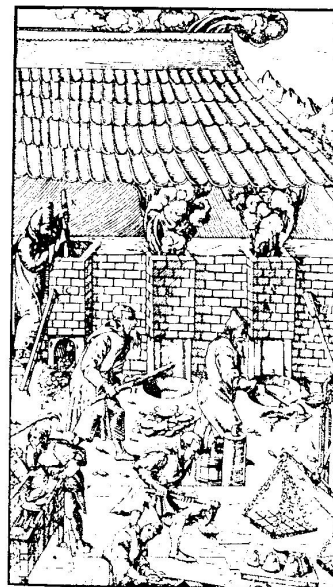
Abb. 41. Ofenanlage mit Vorherden zur Edelmetallextraktion. Der linke Ofen wird beschickt, der mittlere Ofen wird gerade abgestochen, damit die Schmelze mit dem am Böden des Vorherdes erkennbaren Blei in Kontakt tritt. Am rechten Ofen wird das mit Edelmetall angereicherte Blei in Formen ausgeschöpft (nach Agricola)
