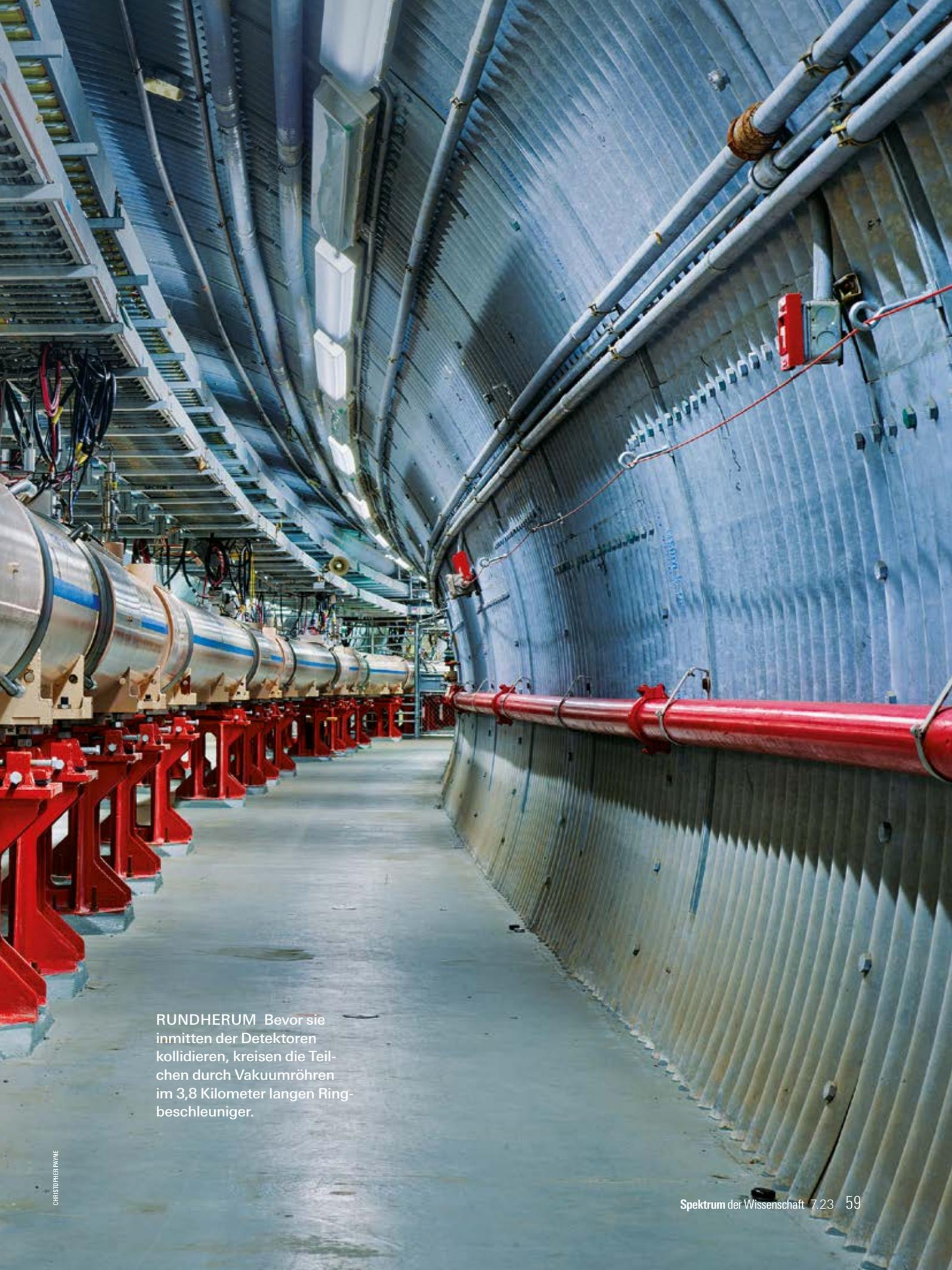
RUNDHERUM Bevor sie inmitten der Detektoren kollidieren, kreisen die Teilchen durch Vakuumröhren im 3,8 Kilometer langen Ringbeschleuniger.
