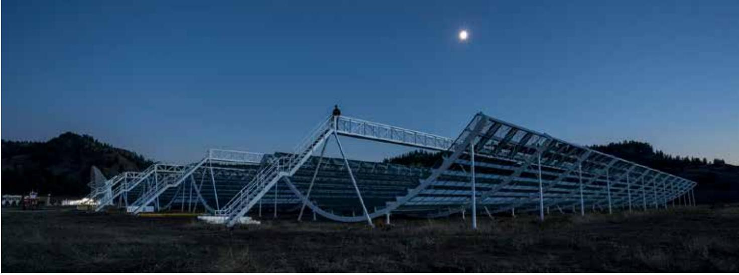
**CHIME-RADIOTELESKOP** Das kanadische Gerät besteht aus vier halbzylinderförmigen Reflektoren. Sie haben keine beweglichen Teile, sondern scannen den Nachthimmel mit der Drehung der Erde nach Strahlungsquellen ab. Dabei fängt CHIME zahlreiche Radioblitz ein.
