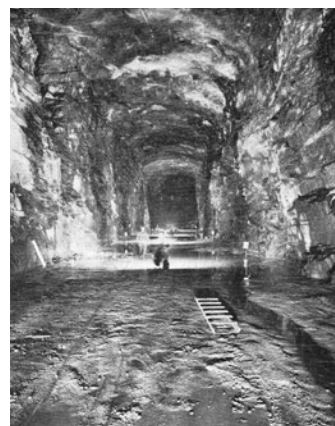
Sprengung in einer finnischen Ölkaverne.
