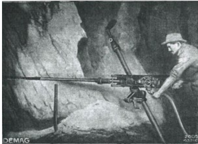
Die Anlage von Kerben und Schlitzen, das Schrämen, ist eine alte Bergbautechnik.
