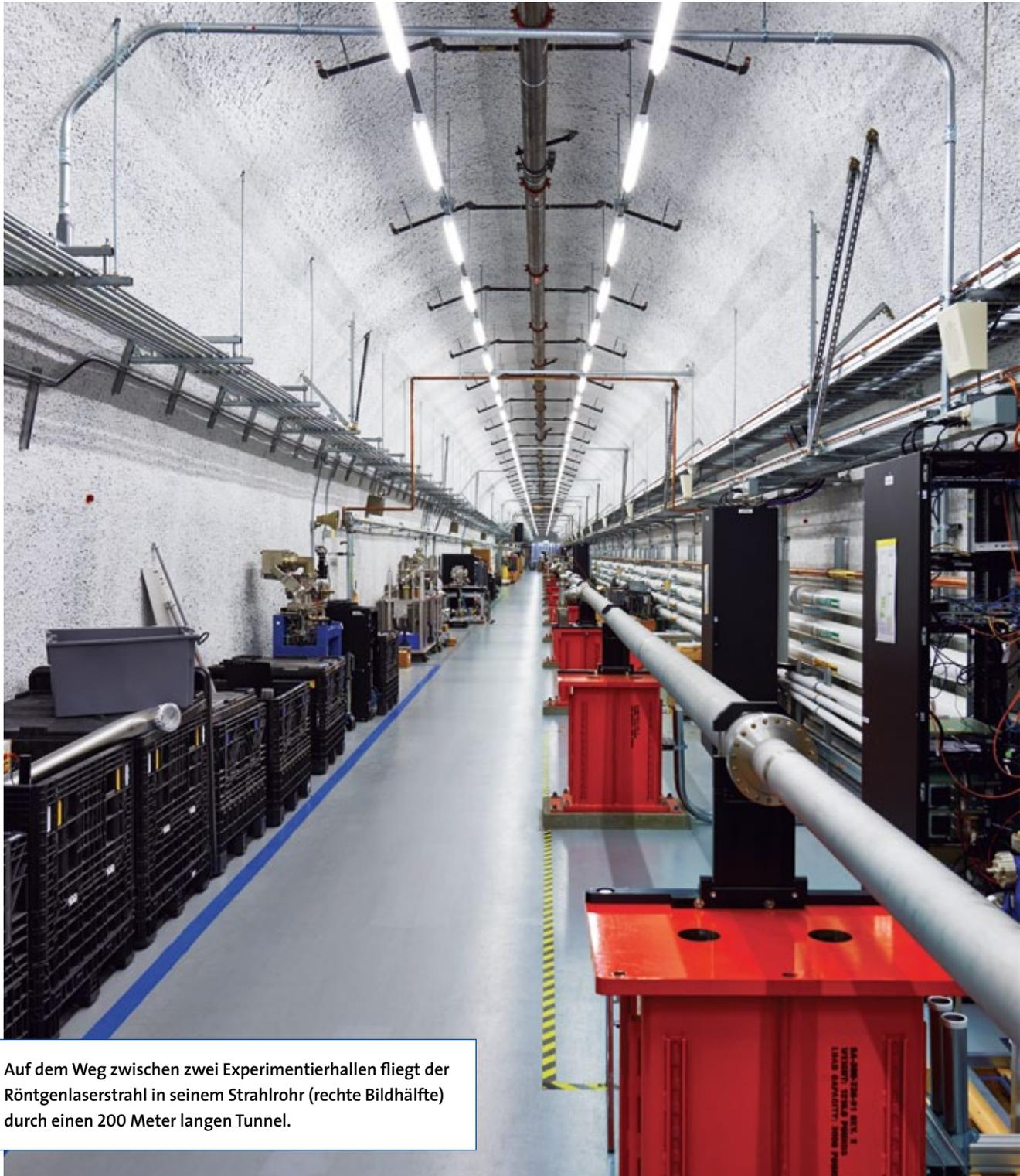
Auf dem Weg zwischen zwei Experimentierhallen fliegt der Röntgenlaserstrahl in seinem Strahlrohr (rechte Bildhälfte) durch einen 200 Meter langen Tunnel.
