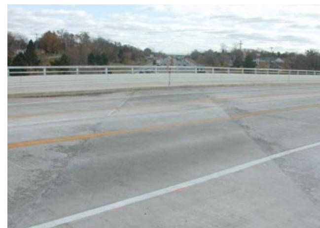
Ein 2005 gegossenes Stück Fahrbahn aus biegsamem Beton auf einer Brücke im Südosten Michigans (oben) schließt sich nahtlos an den Asphalt links und rechts an. Die ECC-Platte übernimmt die Funktion einer herkömmlichen Dehnungsfuge. Während diese Fugen sonst schnell verschleißen, erfüllt sie bis heute ohne jede Reparatur ihre Aufgabe (unten).
