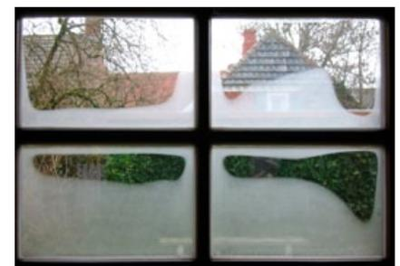
Nach unten hin sind diese Scheiben stärker beschlagen, und auch entlang der Fensterkreuze ist es zu ausgeprägter Kondensation gekommen. Grund für die auffälligen Muster sind Luftströmungen.
