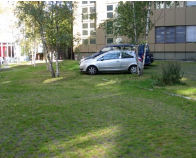
Parkplätze mit Rasengittersteinen können Niederschläge aufnehmen. Weil durch die Vegetation mehr Wasser verdunstet, schwächen sie zudem den Wärmeinseleffekt von Städten ab.
