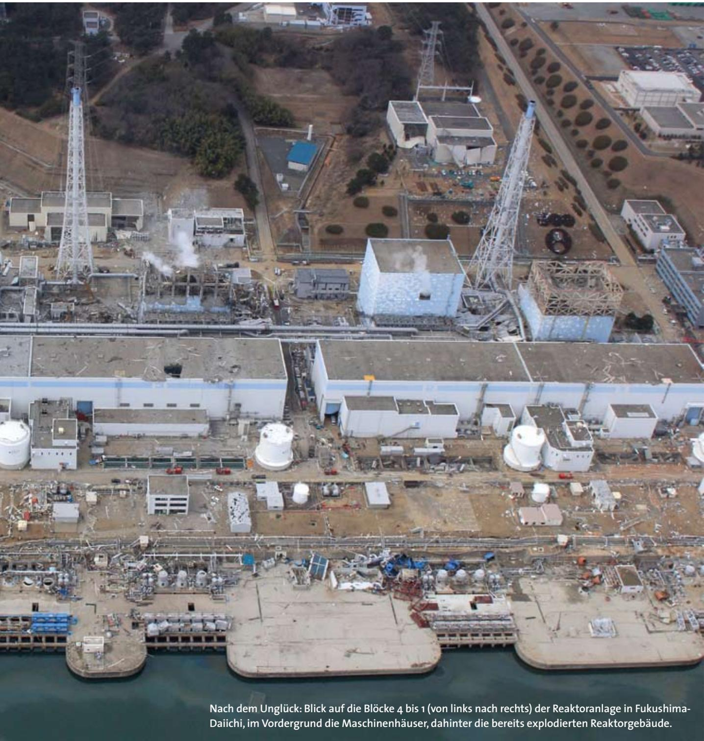
Nach dem Unglück: Blick auf die Blöcke 4 bis 1 (von links nach rechts) der Reaktoranlage in Fukushima-Daiichi, im Vordergrund die Maschinenhäuser, dahinter die bereits explodierten Reaktorgebäude.
