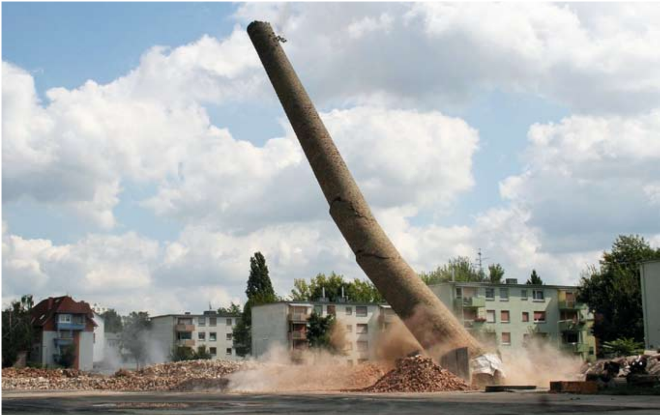
Gemauerte Schornsteine brechen beim Umfallen meistens so durch, dass die Innenseite des Knicks nach oben zeigt.
