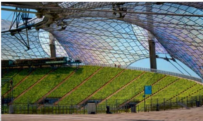
Plexiglas ermöglichte die kühne Dachkonstruktion des Münchner Olympiaparks (links). Meist aber kommt dieser Kunststoff bei Massenprodukten zum Einsatz wie etwa beim Fahrzeugrücklicht (unten).
