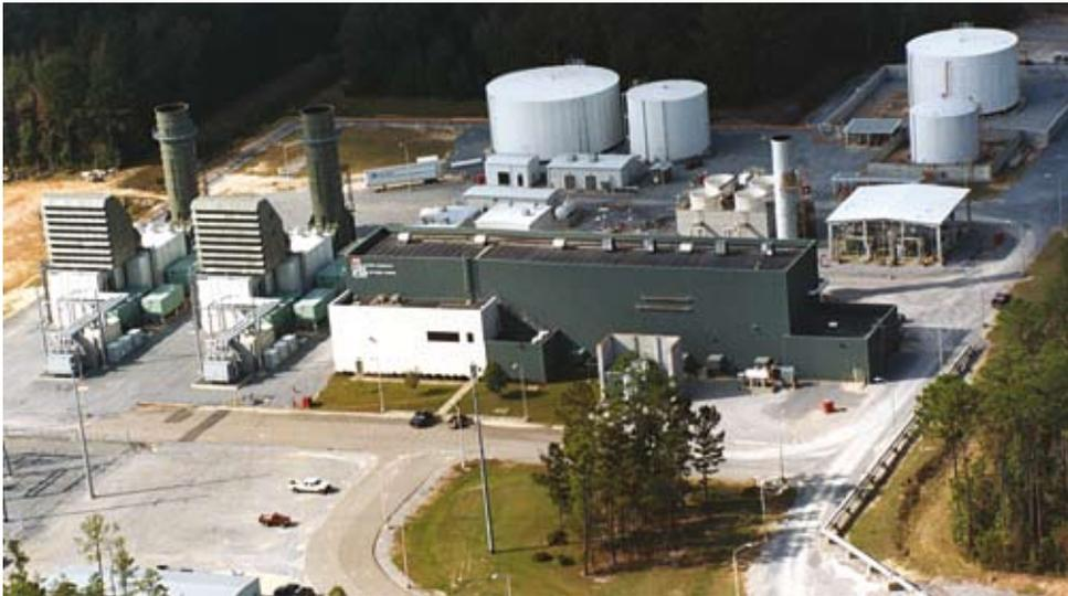
Überschüssige Elektrizität, die Fotovoltaikanlagen tagsüber erzeugen, kann mit Hilfe von Überlandleitungen zu Druckluftenergiespeichern in der Nähe großer Städte geleitet werden. Diese Technologie ist bereits verfügbar. Die Anlage der PowerSouth Energy Cooperative in McIntosh im US-Bundesstaat Alabama ist schon seit 1991 in Betrieb.
