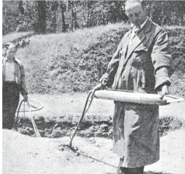
Aushubarbeiter mit Projektil nach vollbrachter Leistung
