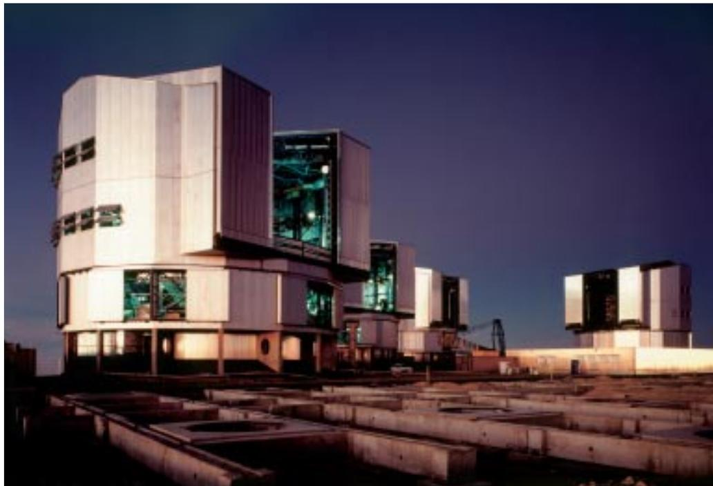
Das Very Large Telescope der Europäischen Südsternwarte auf dem Paranal in Chile besteht aus vier Teleskopen mit einem Durchmesser von jeweils 8,2 Metern, die zu einem Interferometer verbunden werden können.
