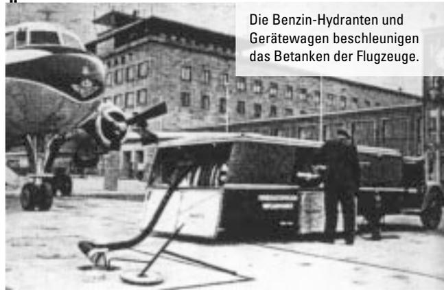
Die Benzin-Hydranten und Gerätewagen beschleunigen das Betanken der Flugzeuge.
