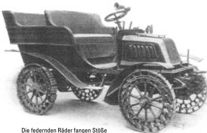
Die federnden Räder fangen Stöße so gut auf, dass die Insassen nicht durchgeschüttelt werden.
