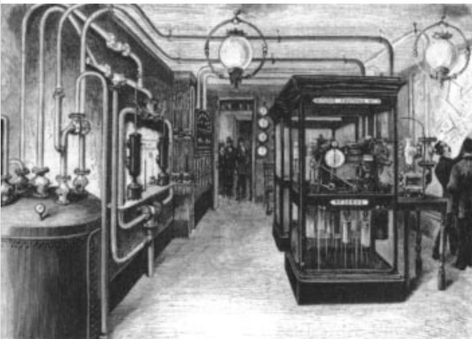
◀ Von diesem Kontrollraum aus wurden um 1880 die öffentlichen Uhren von Paris durch pneumatische Signale synchronisiert.
