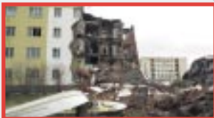
tauender Permafrostboden verursacht Schäden
